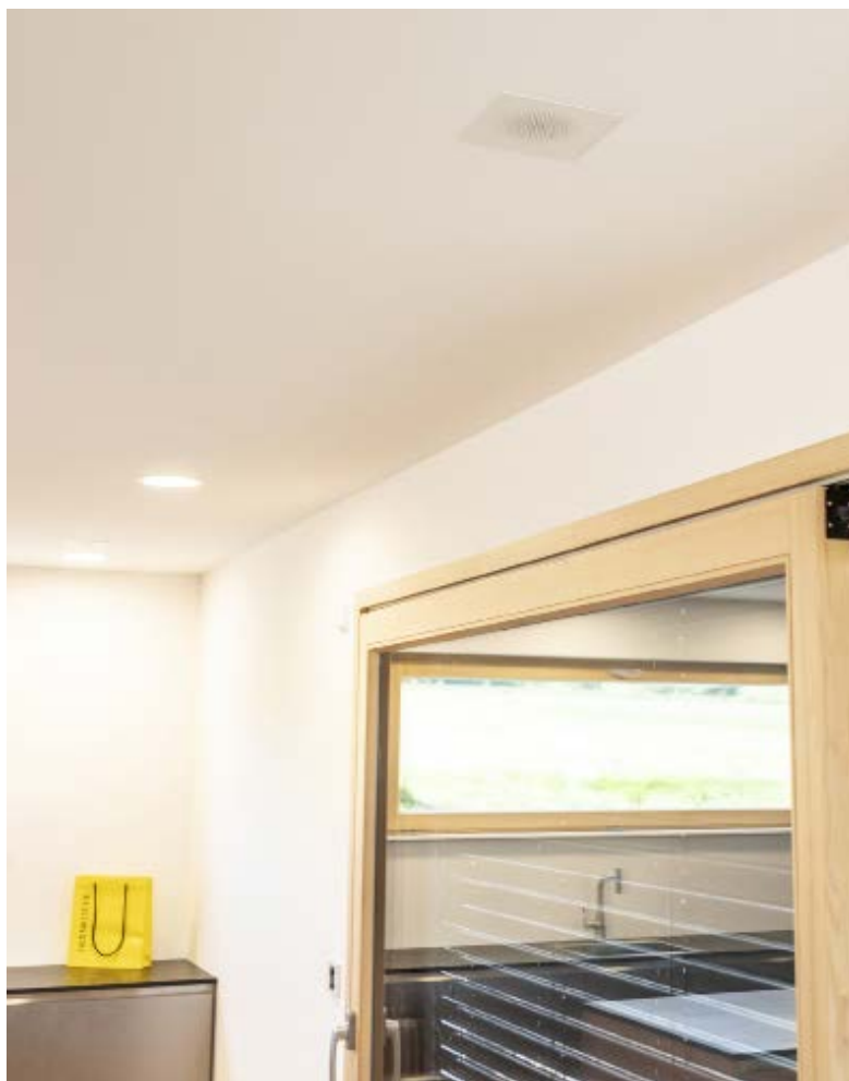
Bild 4 • Die star-line-Designgitter passen sich dem Einrichtungsstil an. Sie sind für den Monteur dank der Magnetbefestigung einfach anzubringen.
