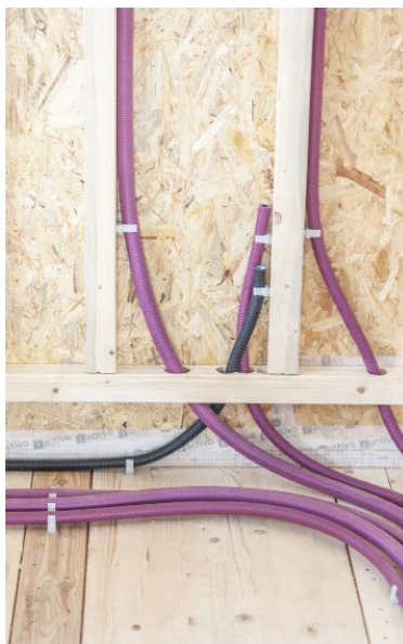
Bild 8 • Das magentafarbene Kunststoffrohr FFKuS-EM-F-105 co2ntrol und das schwarze FBY-EL-F co2ntrol ermöglichen mit ihrer hochgleitfähigen Innenschicht den mühelosen Einzug langer Leitungen.
