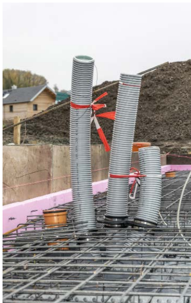
Bild 5 • Das Kabu-FESH-Set Elektro B sorgt für die normkonforme Haus-einführung. Kabuflex R plus Typ 750 übernimmt den Schutzrohranschluss von Strom sowie Glasfaser.
