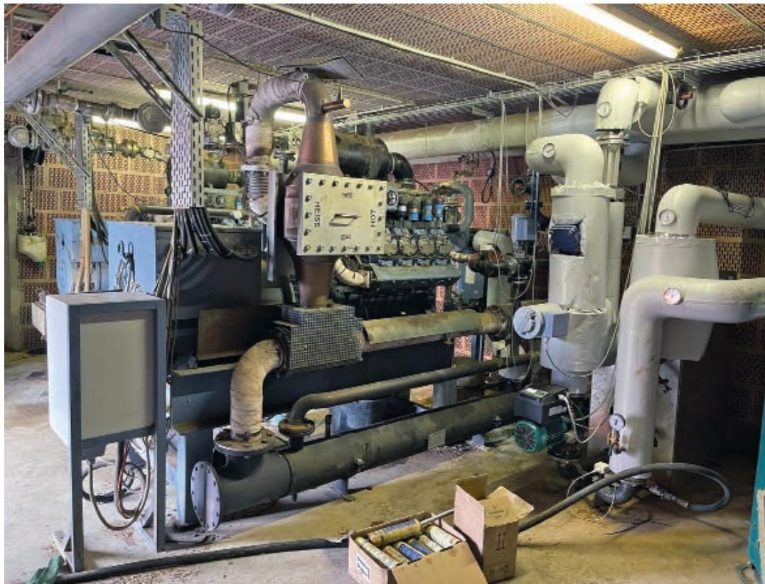
▲ Das Blockheizkraftwerk (BHKW) kann bis zu 600 kW elektrischer Leistung und Wärme für bis zu 1.200 Haushalte durch Einspeisung in das Fernwärmenetz erzeugen. Bild: Orben
