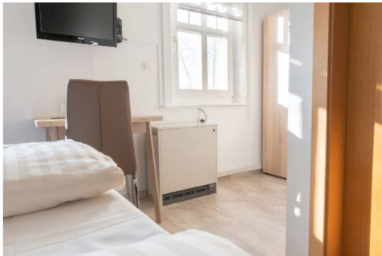
Bild 2 • Die in die Jahre gekommenen Wärmespeicheröfen machten in den Gästezimmern auch optisch nicht mehr den besten Eindruck.
