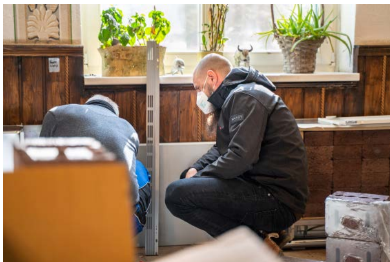
Bild 4 • Die Installation der neuen Wärmespeicher ging schnell, problemlos und ohne größere Störung des Hotelbetriebs vorstatten.
