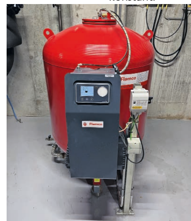
▼ Bild 5 • Der kompakte Druckhalteautomat hält den Systemdruck auf 0,2 bar genau konstant.
