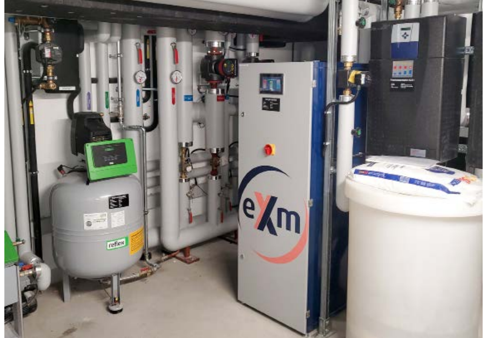
Bild 2 • Dank der eXergiemaschine (Mitte) lässt sich Abwärme der Bäckerei, die von deren Kälteanlagen erzeugt wird, für das Heizen und die Warmwasserbereitung verwenden.
