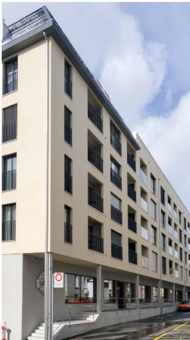
Bild 1 • Mit über 50 Apartments hat das Boarding House in St. Gallen ein ähnliches Warmwasser-Verbrauchsprofil wie ein Hotel. Entsprechend großzügig ist der Wärmespeicher der Heizzentrale ausgelegt. Bild: Abler
