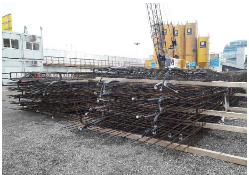
Bild 4 • Vorfertigung der Schlitzwand-Absorber. Die Bewehrungskörbe für die Tiefgründungselemente werden auf der Lagerfläche von Enercret-Mitarbeitern mit Rohrleitungen belegt und geprüft. Die Bewehrungskörbe werden später durch das Spezialtiefbau-Unternehmen eingebaut.
