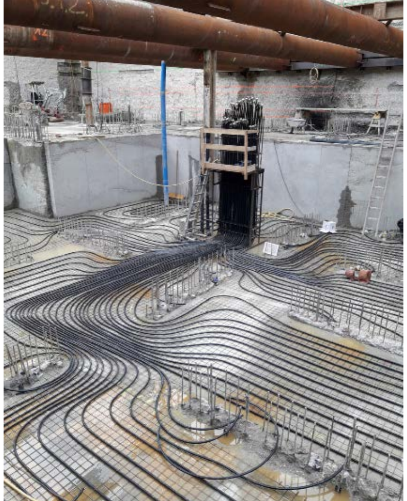
Bild 3 • Anschluss der aktivierten Tiefgründungselemente sowie der Bodenplattenaktivierung. Auf einer Gesamtfläche der beiden Bodenplatten von rund 2.970 m 2 verlegen die Monteure Absorberrohre.
