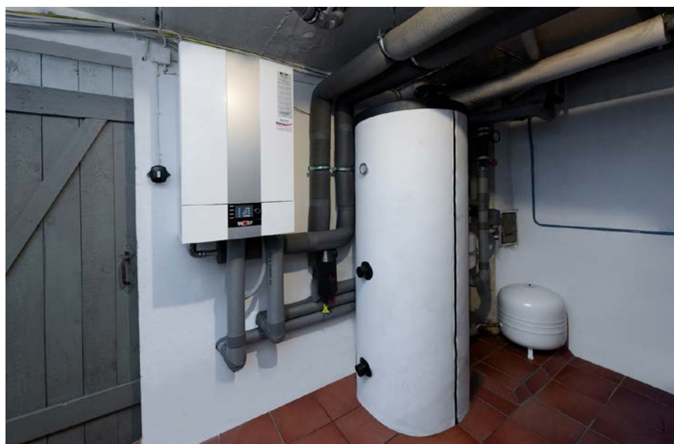
▲ Bild 3 • Die neue Wärmepumpen-Heizung ist konservativ aufgebaut; das heißt, als große Komponenten sind die Innen- und Außeneinheit sowie ein 300 Liter Warmwasserspeicher eingebaut.
