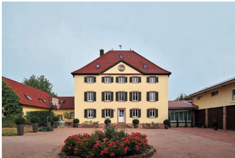
Bild 2 • Die Galmbacher Sport Pferde Zucht setzt für die Beheizung des Schlossguts Bernersried und die Nebengebäude auf klimafreundliche Ochsner Luft/Wasser-Wärmepumpen.
