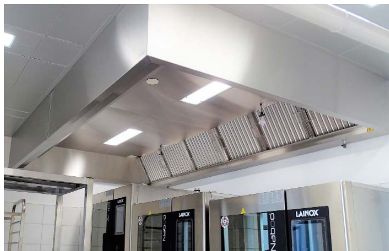
Bild 4 • Hybrid-Lüftungsdecke in einer Catering-Küche.
