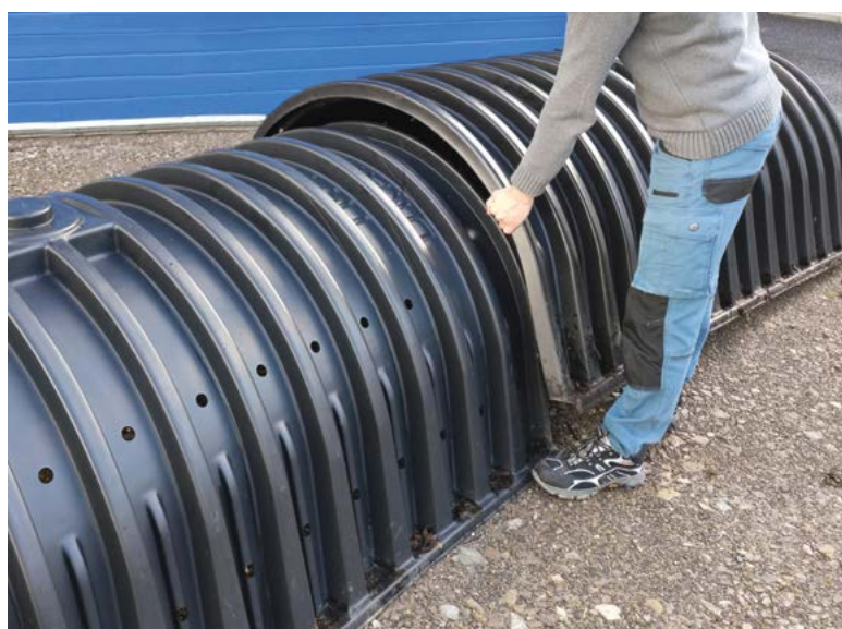
Bild 2 • Verbinden von zwei Mitteltunnel-elementen.
