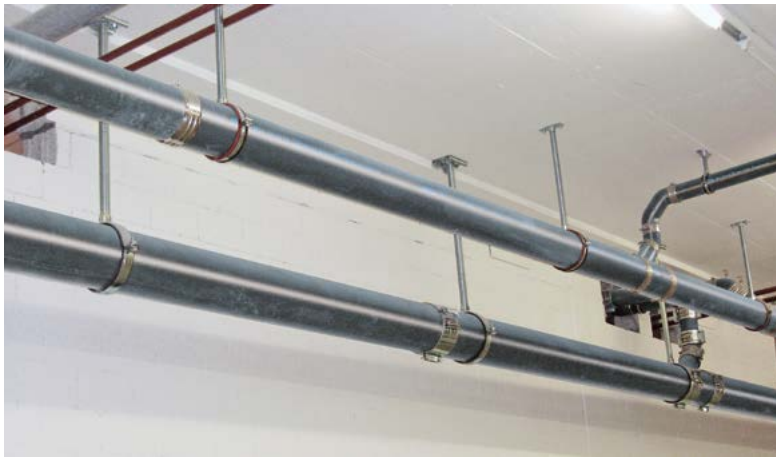
▲ Bild 7 • „Nichtbrennbares, gusseisernes Abflussrohrsystem mit Sonderbeschichtung Typ MLK-protec“ (Düker).
