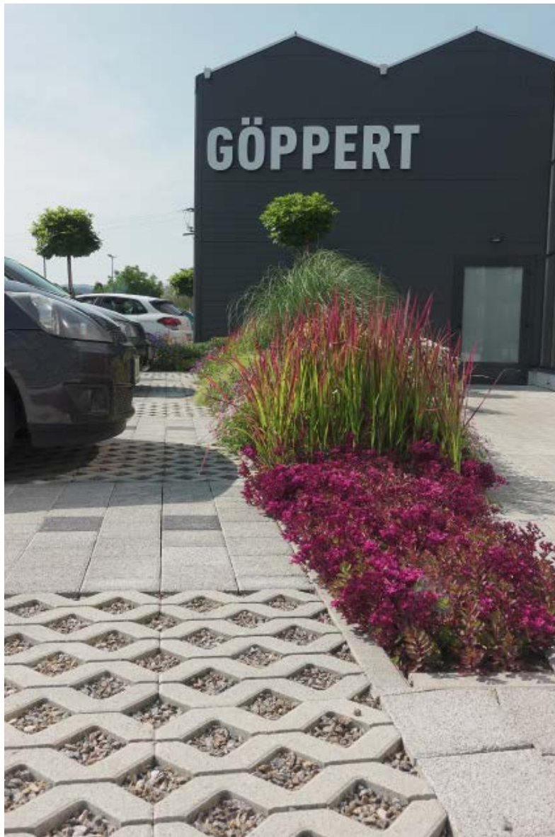
Bild 1 • Gartencenter Göppert am Stadtrand von Haslach im Kinzigtal/Ortenaukreis. Bei der letzten Betriebs-erweiterung 2019 wurde unter anderem die Wiederverwendung von Niederschlagswasser in das Bewässerungssystem integriert. Ungenutztes Regenwasser wird versickert. Die Kunden-Stellplätze sind waserdurchlässig. Bild: König
