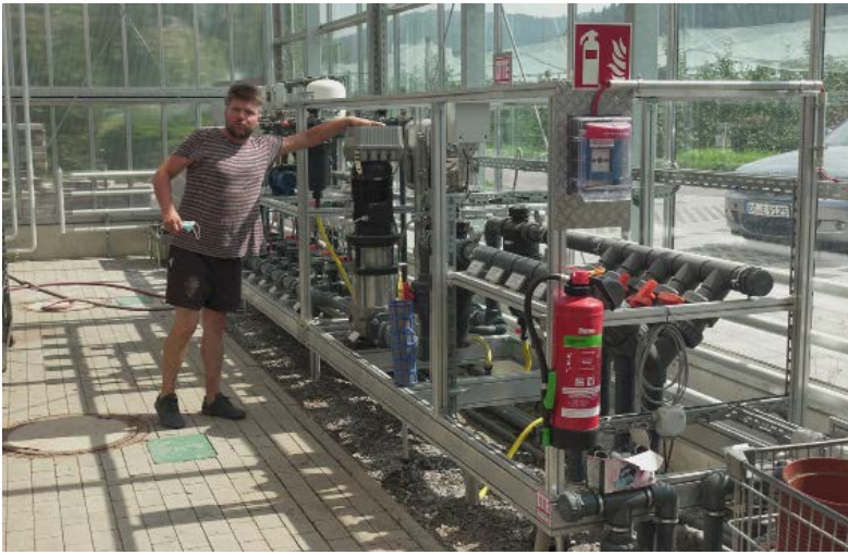
Bild 4 + 5 • Installation der Bewässerungstechnik, von der für jede Pflanzenkultur eine andere Wassermenge und -qualität bereitgestellt wird. Das erfordert passende Leitungen und Pumpen sowie unterschiedlichen Wasserdruck für Wurfregner im Freiland bzw. Handbrausen, Sprühdüsen und Flutventile der Pflanztische im Gewächshaus.
