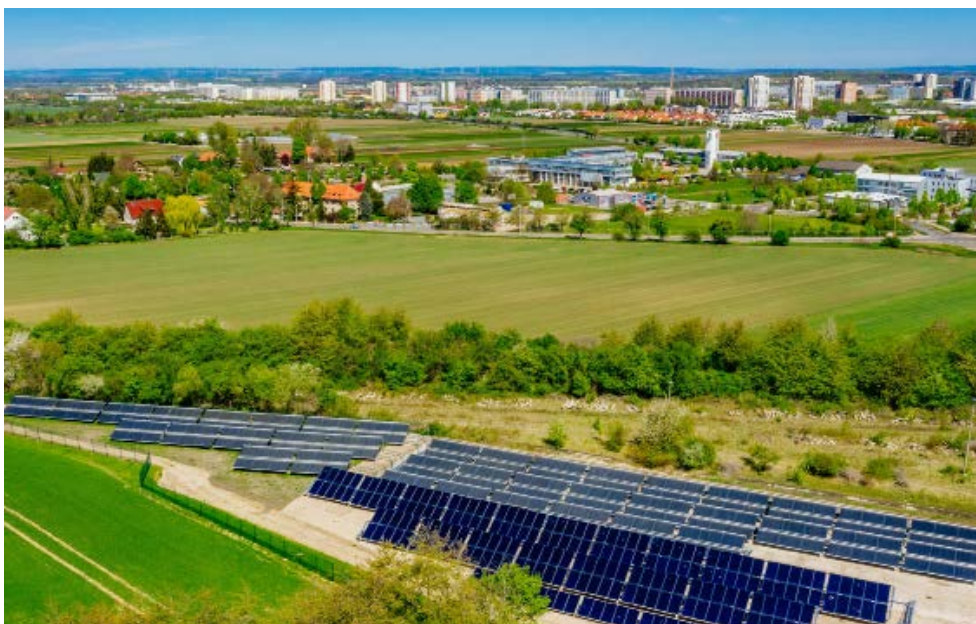
Bild 6 • Zwei Kollektorfelder für Fernwärme in Erfurt
