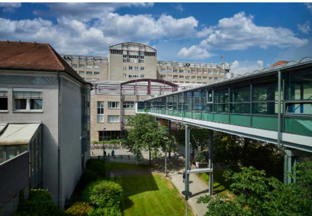
Bild 1 • Im laufenden Betrieb werden aktuell im Gebäude 505 der Universitätsmedizin Mainz rund drei Dutzend Nasszellen plus die zugehörigen Sanitärinstallationen kernsaniert.
