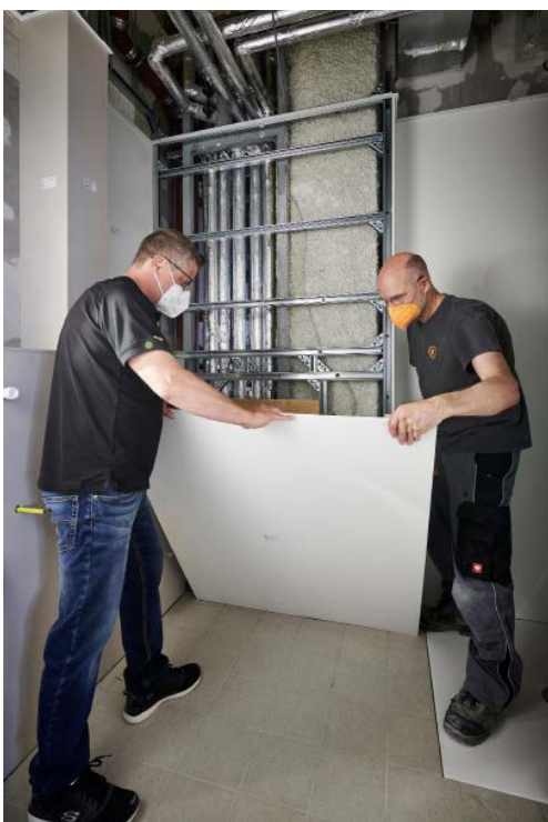
Bild 3 • Montagefertig: Für den Fotografen demonstrieren Viega-Verkaufsberater Udo Bachmann (li.) und Bauleitender Obermonteur Frank Ims von der Firma Käuffer, wie einfach die maßgenauen „MuroLive!“-Verkleidungsplatten dank Clip-Technik an der Vorwandkonstruktion befestigt und wieder gelöst werden können.
