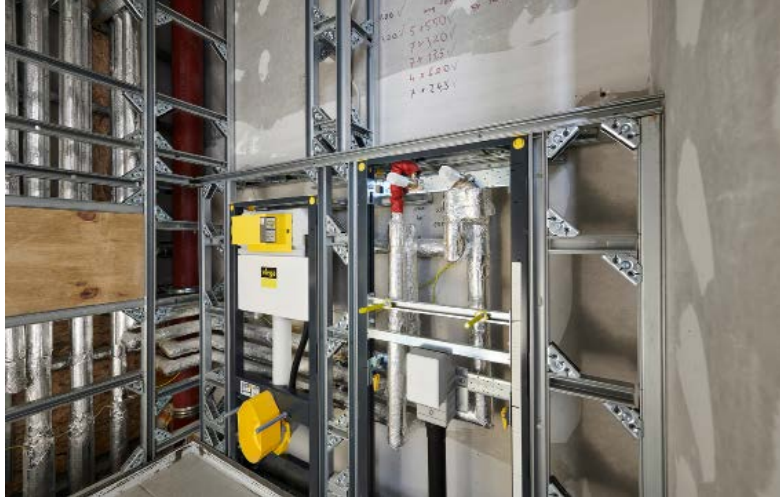
Bild 2 • Das Vorwandssystem „Prevista Dry Plus“ ist für die Sanierung der Nasszellen ideal, weil die Räume damit vor Ort zentimetergenau ausgestattet werden können.
