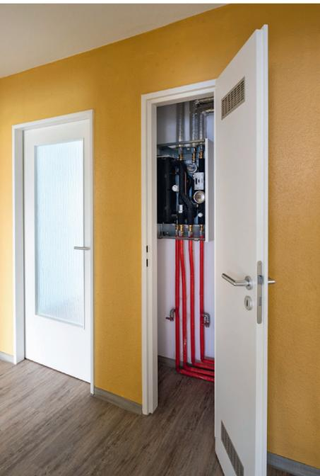
▲ Bild 5 • Die Wohnungsstation WSP von Stiebel Eltron: Hier wird die Wärme des zentralen Erzeugers an das Heizsystem übergeben und für die hygienische Warmwasserbereitung genutzt.
