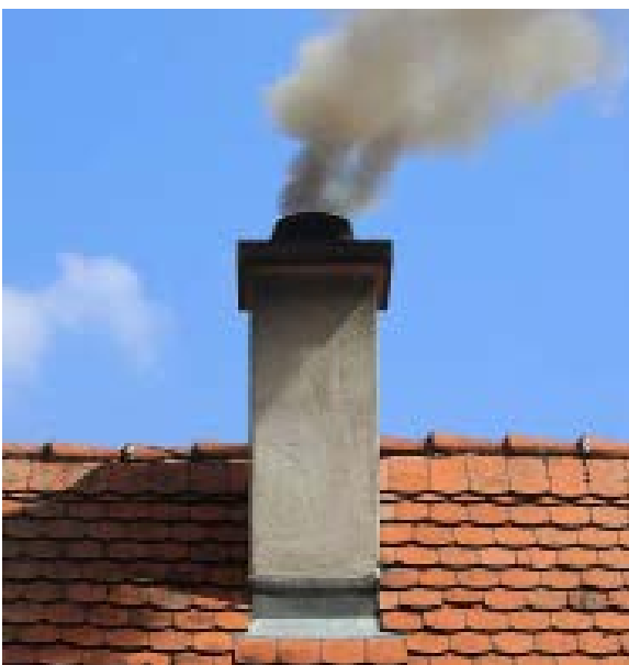
Bild 1 • Kleinfeuerungsanlagen für feste Brennstoffe tragen aufgrund ihrer geringen Ableitungshöhe erheblich zur Immissionsbelastung bei.
