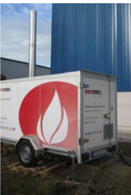
▼ ▲ Bild 4 • Eine mobile Heizzentrale mit einer Leistung von 150 kW lieferte die Wärme für die im Bau befindliche Halle.
