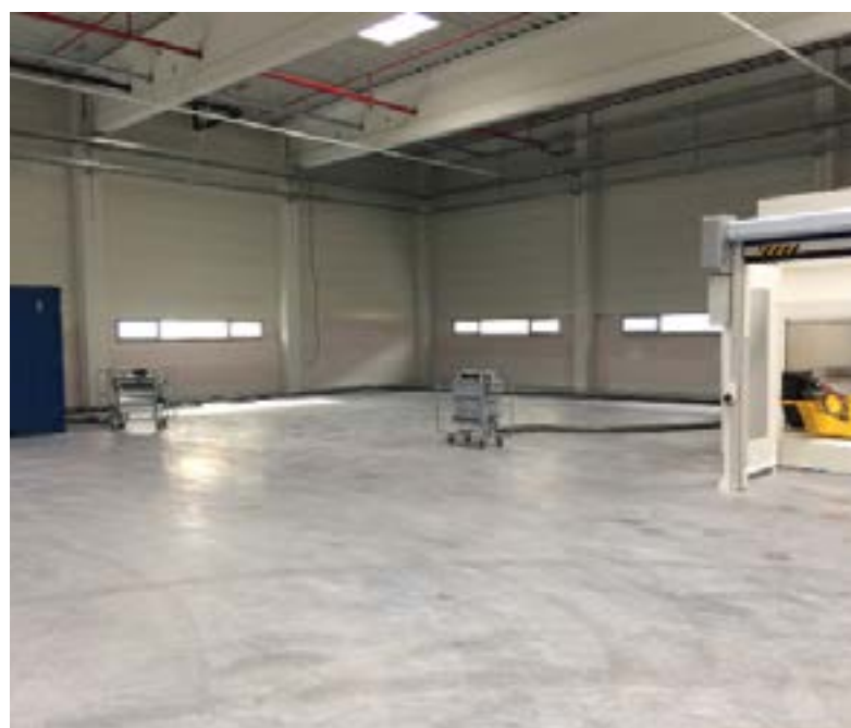
▼ ▲ Bild 4 • Eine mobile Heizzentrale mit einer Leistung von 150 kW lieferte die Wärme für die im Bau befindliche Halle.
