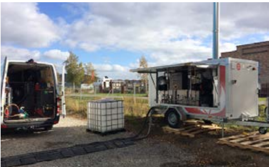
▼ ▲ Bild 4 • Eine mobile Heizzentrale mit einer Leistung von 150 kW lieferte die Wärme für die im Bau befindliche Halle.
