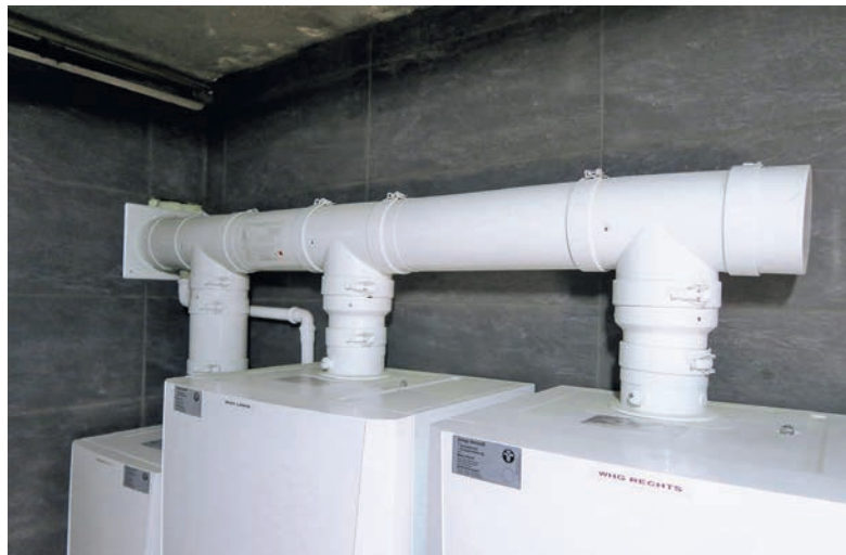
Bild 8 • Die Abgaskaskade ist als konzentrisch ausgeführte PP-Leitung bis zu einer Abgastemperatur von 120 °C zugelassen.
