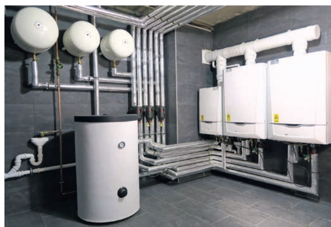
Bild 3 • Moderne Gasbrennwerttechnik mit 85 kW Gesamt-Nennheizleistung in edlem Ambiente. Der bestehende Heizraum wurde mit Feinsteinzeug ausgedeckt.
