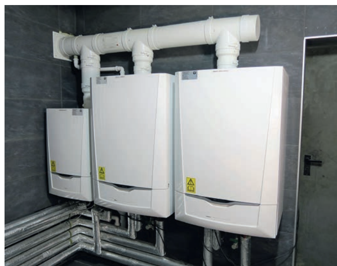
Bild 2 • Die kompakte Gehäusekonstruktion der Calenta Ace-Geräte ermöglicht eine problemlose Einbringung auf kleinstem Raum.
