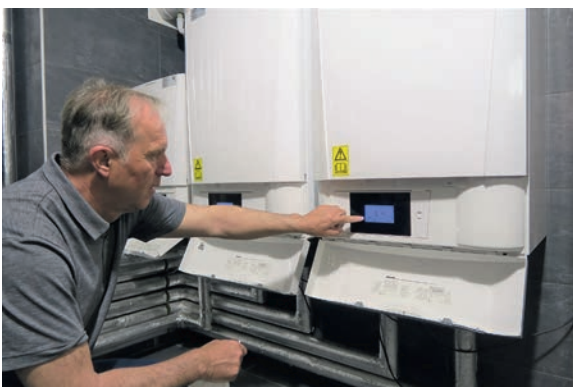
Bild 6 • Überzeugt durch klare Symbolik und eine intuitive Menüführung: die Regelungsplattform Ace Controls. Gebietsverkaufsleiter Hans-Ulrich Rödel erläutert das Display.
