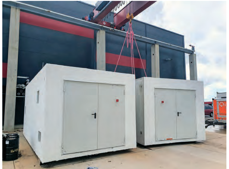
Bild 3 • Die zwei identischen Betonraumzellen wurden in Hoyerswerda gefertigt und danach getrennt an ihren Bestimmungsort transportiert. Am Zielort bestand die Herausforderung darin, beide Zellen zu einer funktionalen Einheit zusammenzufügen.
