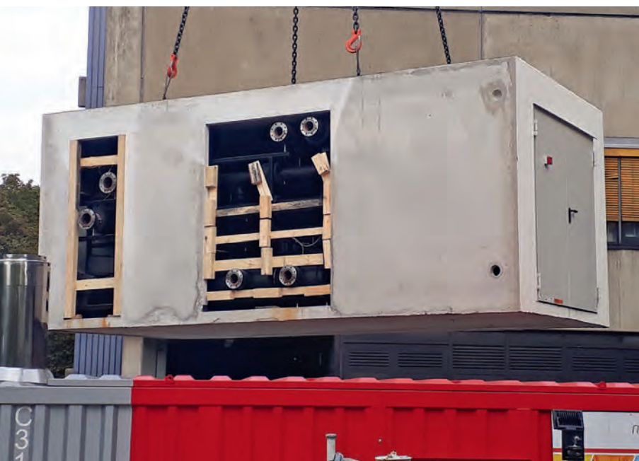
Bild 1 • Bereit für den Transport: Auslieferung einer anschlussfertigen Betonraumzelle, die von YADOS komplett vormontiert wurde.
