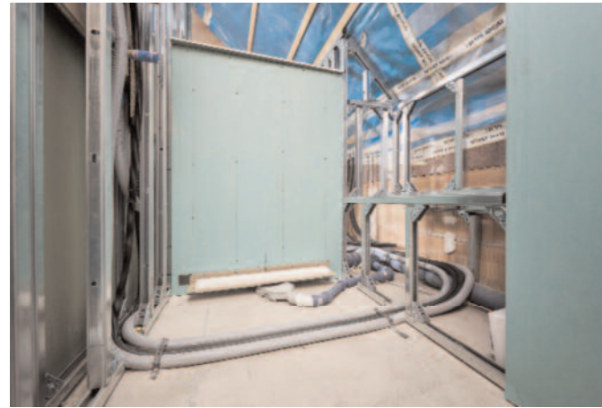
◀ Bauphase: Die Vorwandinstallationselemente werden aufgebaut und sind hier bereits teilweise verplankt. Bild: Viega
