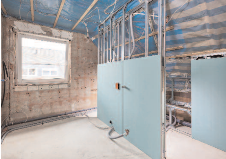
◀ Bauphase: Die Vorwandinstallationselemente werden aufgebaut und sind hier bereits teilweise verplankt. Bild: Viega
