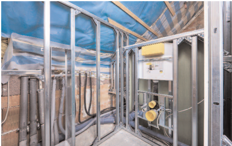
▲ Die Zwischenräume der einzelnen Vorwandelemente nehmen zum Beispiel die Vorrichtungen für das WC auf oder lassen, wie in unserem Beispiel Platz zur formschönen Integration von WC-Bürstengarnitur und Toilettenpapierhalter. Bild: Viega
