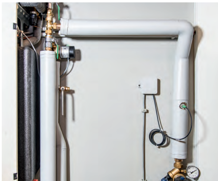
◀ Bild 7 • Ein Volumensensor misst die Wassermenge, die innerhalb eines Bungalows durch die Leitung gespült wird und prüft, ob und mit welcher Wassermenge ergänzend gespült werden muss.
