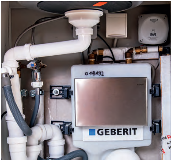
◀ Bild 4 • Die Geberit Hygienespülung ist versteckt unter der Küchenspüle eingebaut. Strategisch geschickt platziert, erneuert sie bei einer Spülauslösung das gesamte Trinkwasserleitungsnetz eines Ferienhauses.
