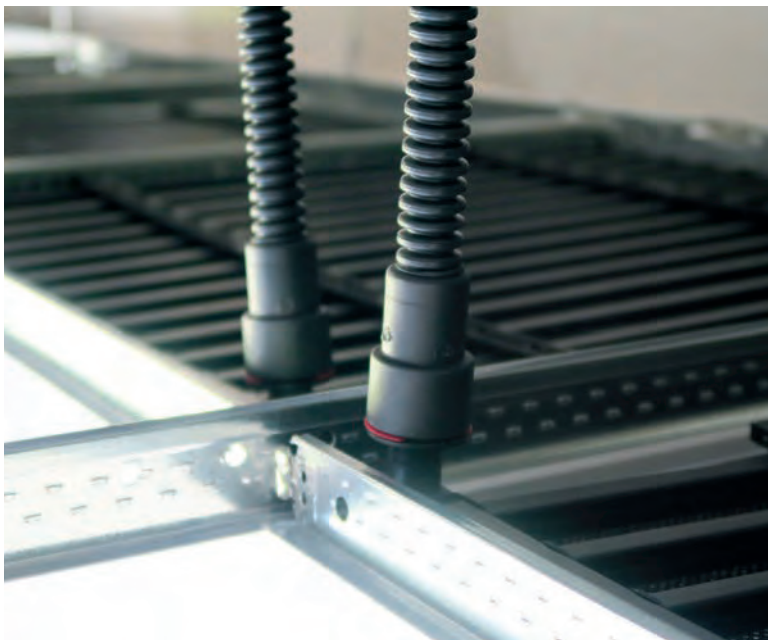
▲ Bild 3 • Die aquatherm black system-Register wurden nicht nur in allen abgehängten Deckenkonstruktionen der Sanitärräume installiert, sondern kommen auch in den Büro- und Verwaltungsräumen zum Einsatz.
