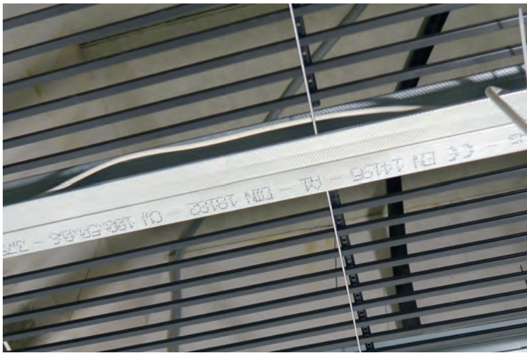
▲ Bild 3 • Die aquatherm black system-Register wurden nicht nur in allen abgehängten Deckenkonstruktionen der Sanitärräume installiert, sondern kommen auch in den Büro- und Verwaltungsräumen zum Einsatz.
