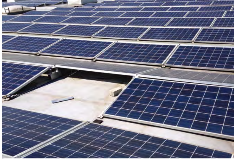
▲ Kräftige Stürme nehmen zu – und nehmen mit, was nicht wirklich solide installiert ist. Bild: Yokk Solar GmbH
