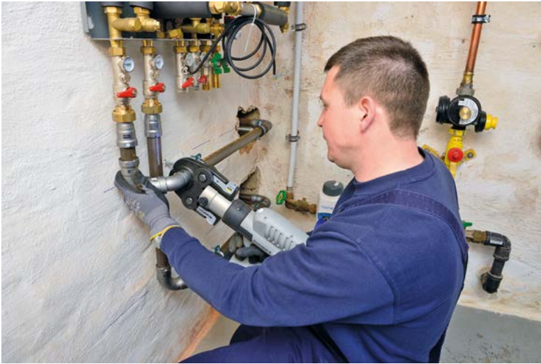
◀ Bild 5 • „Die Zeitersparnis ist enorm!“ Das ist das einhellige Fazit der Rohrnetzmonteure bei der Neuinstallation der Wärmeübergabestation im Haus an der Rosenstraße, mit Anbindeleitungen aus dickwandigem Stahlrohr und dem System „Megapress S“.
