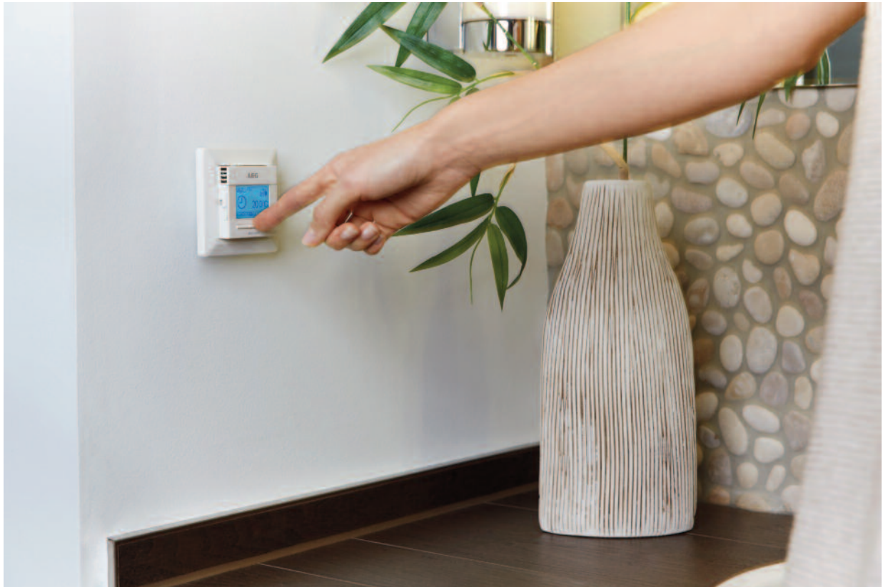
Bild 1: Die passende Temperatur zur Wunschzeit: Mit elektronischen Reglern lassen sich Fußbodentemperierungen zeitgesteuert voreinstellen.
