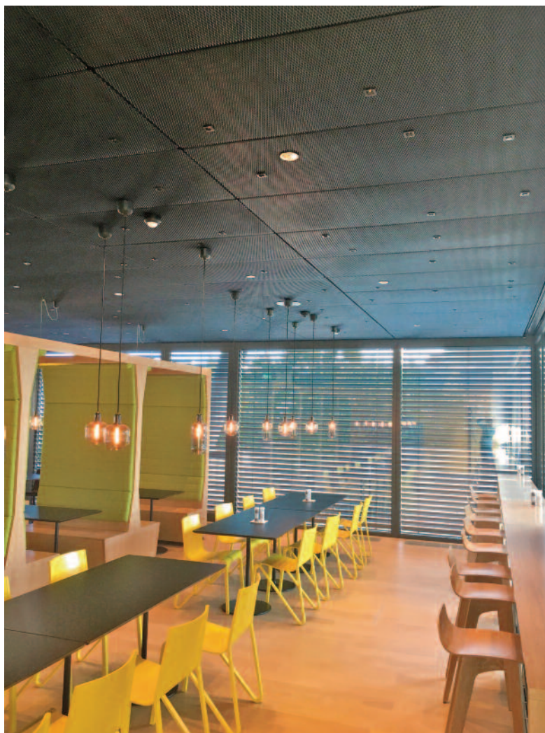
▲ Bild 5 • Im firmeneigenen Mitarbeiterrestaurant wurde eine 280 m 2 große Varicool Streckmetalldecke installiert, die neben der optimalen Temperierung maßgeblich zum offenen und modernen Charakter des Bereichs beiträgt. Bild: Uponor / Zent-Frenger
