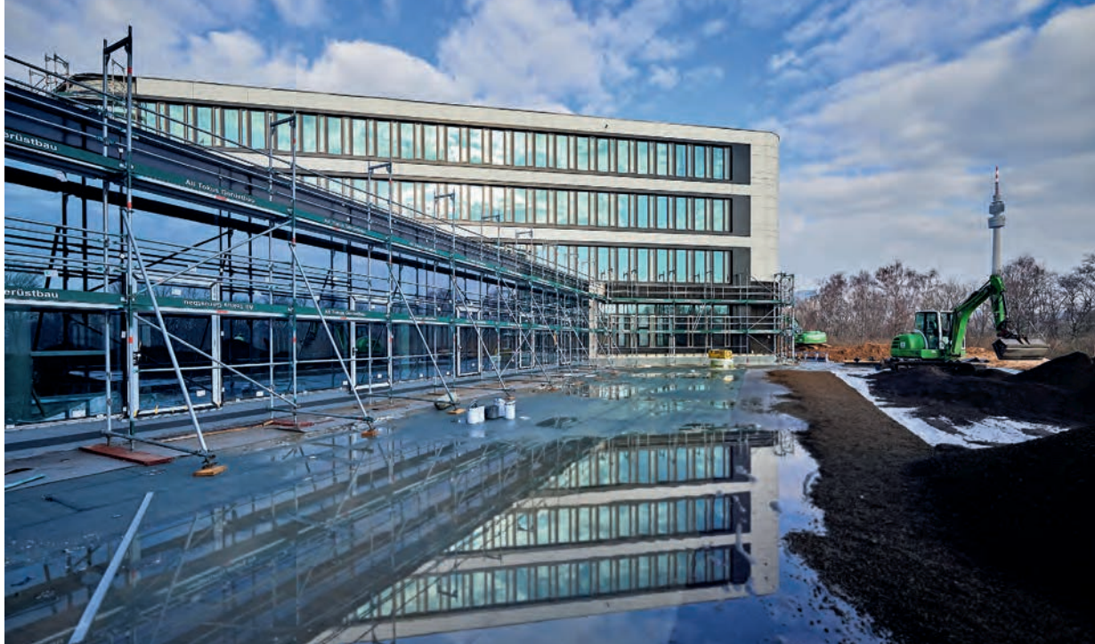
Bild 1 • Mehr als 39 km Rohrleitungen hat das Fachhandwerksunternehmen Zilisch in dem neuen Verwaltungsgebäude allein für Heizung und Kühlung installiert. Neben dem Rohrleitungssystem „Megapress“ (Stahl) kamen dabei auch die Systeme „Sanpress Inox“ (Edelstahl für die Kälteverteilung auf der Etage) und „Raxofix“ (Mehrschichtverbundrohr für die Verteilungen Heizung) zum Einsatz.
