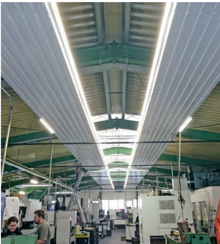
Bild 4 • KSP to go – das Beispiel zeigt die Verbindung mit einseitig montierter LED-Beleuchtung sowie Einzelleuchten.
