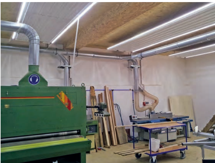
Bild 3 • Ideale Kombination – angenehme Strahlungswärme und die beidseitig angebrachte LED-Beleuchtung, hier in einer Schreinerei.
