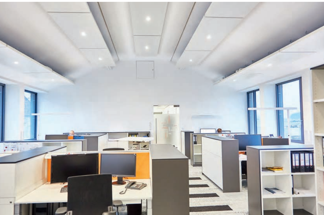
▲ Bild 5 • Dank flexibler Anpassung war der Einbau der Deckensegel auch in den Deckenschrägen problemlos möglich.
