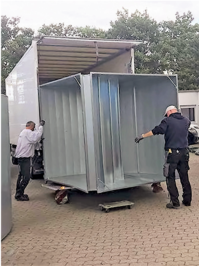
◀ Bild 3 • Typische Transportschäden mit negativen Auswirkungen auf die Dichtheit der Luftleitungskomponenten und damit des gesamten Systems entstehen beispielsweise dadurch, dass insbesondere große Luftleitungsbauteile sich bei der Handhabung verziehen.
