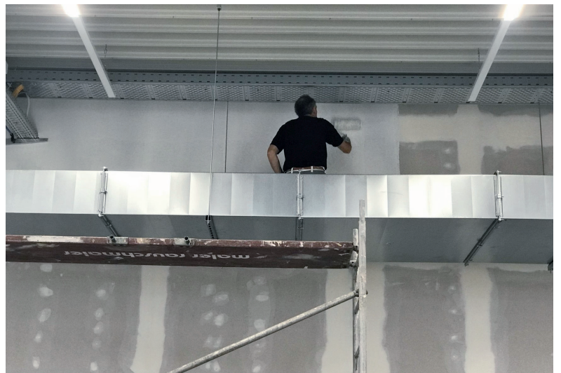
▼ Bild 8 • Außer dem Anlagenbauer haben auch andere Gewerke erheblichen Einfluss auf die Dichtheit des finalen Luftleitungssystems. Beispielsweise ist es keine Seltenheit, dass Luftleitungsbauteile als Sitzgelegenheit genutzt werden.
