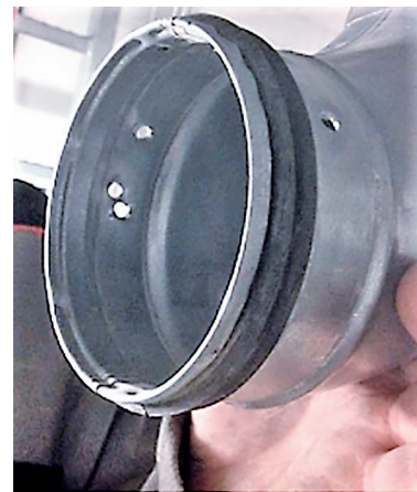
◀ Bild 5 • Löcher, die bei Montagen nach dem „Try and Error“-Verfahren entstehen, werden in vielen Fällen nicht abgedichtet, sondern verbleiben als Leckagen im Luftleitungssystem.
