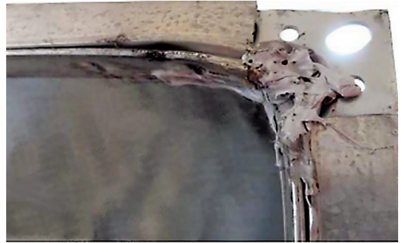
◀ Bild 5 • Löcher, die bei Montagen nach dem „Try and Error“-Verfahren entstehen, werden in vielen Fällen nicht abgedichtet, sondern verbleiben als Leckagen im Luftleitungssystem.
