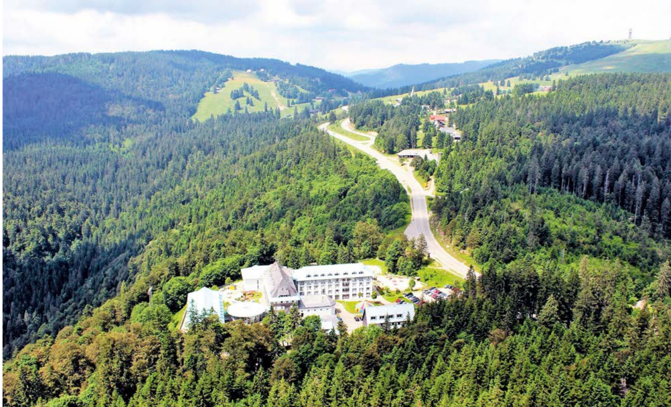
▲ Bild 1 • Das Caritas-Haus Feldberg liegt 1.200 m ü. M. (Feldberggipfel rechts oben). Das macht sich bereits in der Luftdichte bemerkbar. Die werkseitige Gemischeinstellung muss korrigiert werden.
