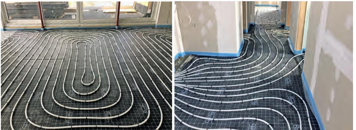
Bild 4 und 5 • Für die Verteilung der Wärme fiel die Wahl auf das Roth Original-Tacker-System.
