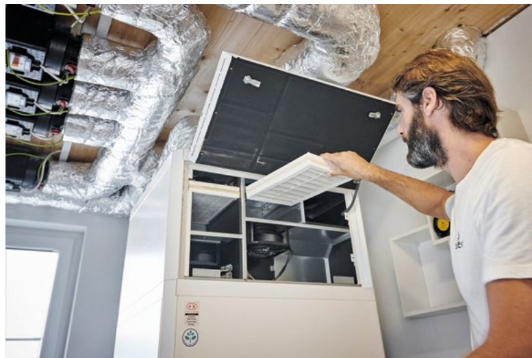
▲ Der Wartungsaufwand für die Kombianlage Genius beschränkt sich im Wesentlichen auf den einfachen Luftfilterwechsel, hier durch Hausherrn Philipp Schrenk. Bild: Systemair
