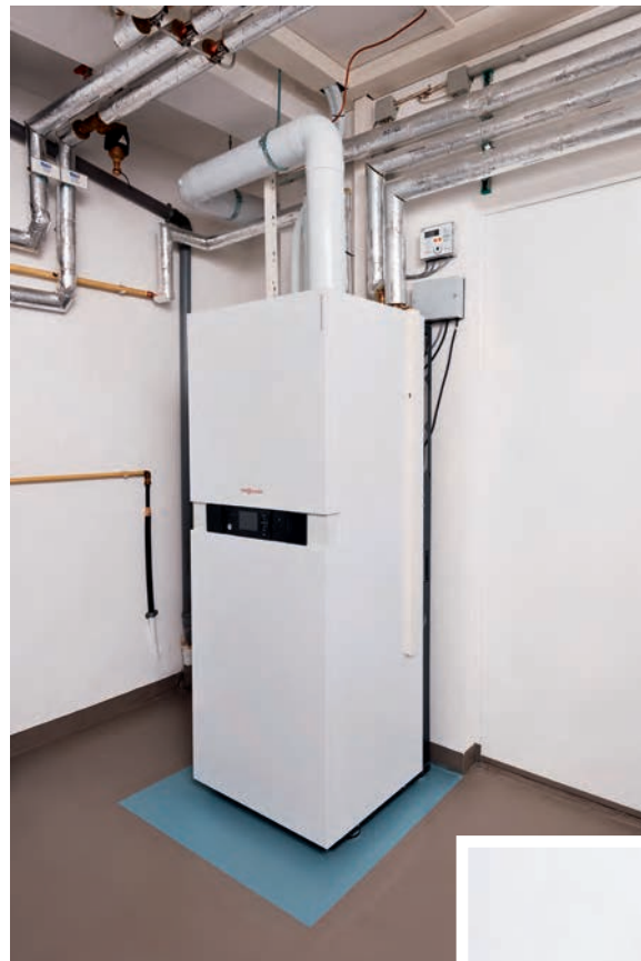
◀ Bild 5a+b • Das Einfamilienhaus verfügt über ein internetfähiges Hybridheizgerät, das Strom-Wärmepumpe und Öl-Brennwertmodul kombiniert.
