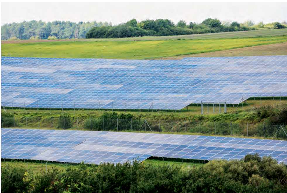
▼ Bild 6 • In Wolfhagen erfolgt die Stromversorgung bereits heute überwiegend auf erneuerbare Weise. Alle Bilder: IWO
