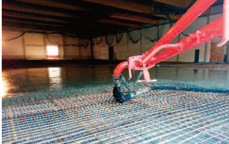
▲ Bild 5 • Die Anforderungen an den Bodenaufbau sind hoch: Gabelstapler- und LKW-Verkehr in der Halle erfordern einen leistungsfähigen Untergrund.
