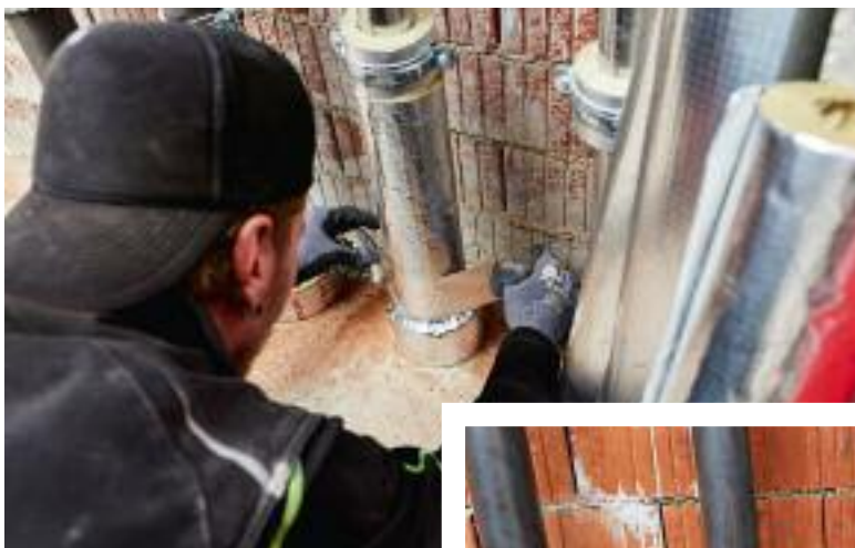
▶ Bild 8 • Das Alutape ist mindestens einmal um den kompletten Umfang zu wickeln und sollte dabei mindestens 20 mm zu beiden Seiten der Fuge überlappen. Für eine zusätzliche Lagesicherung werden die Rohrschalen im Abstand von maximal 600 mm umwickelt.
