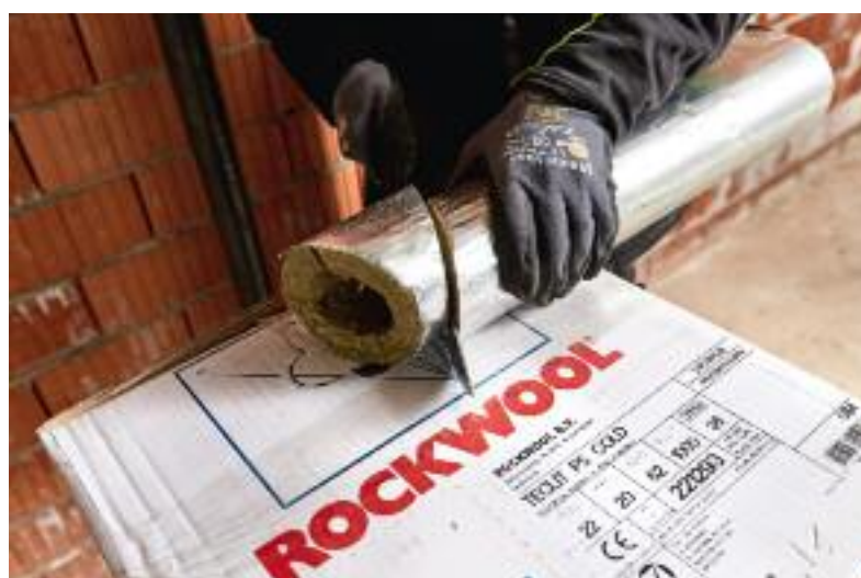
▶ Bild 9 • Mithilfe der auf die „TECLIT“-Verpackung aufgedruckten Zuschnittschablone ist das Erstellen von exakten 45- oder 90-Grad-Winkeln ein Kinderspiel. Außerdem hilft hier die 45-Grad-Linierung auf der Alufolie.
