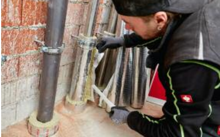
◀ Bild 6 • Rohrschale für warmgehende Leitungen ist auch die „TECLIT PS Cold“ in Kombination mit der „Conlit 150-U“ Brandschutzabschottung geprüft. Isolierer können somit problemlos sämtliche haustechnischen Leitungen mit zuverlässigen Systemen aus nichtbrennbarer Steinwolle dämmen.
