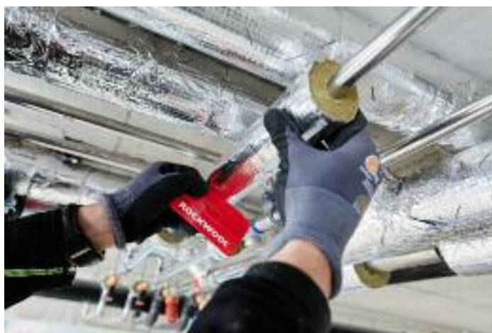
◀ Bild 5 • Wichtig beim Verschließen der Fugen: Die Klebeflächen sollten zum Beispiel mit einem Spachtel oder Rakel glatt gestrichen werden.
