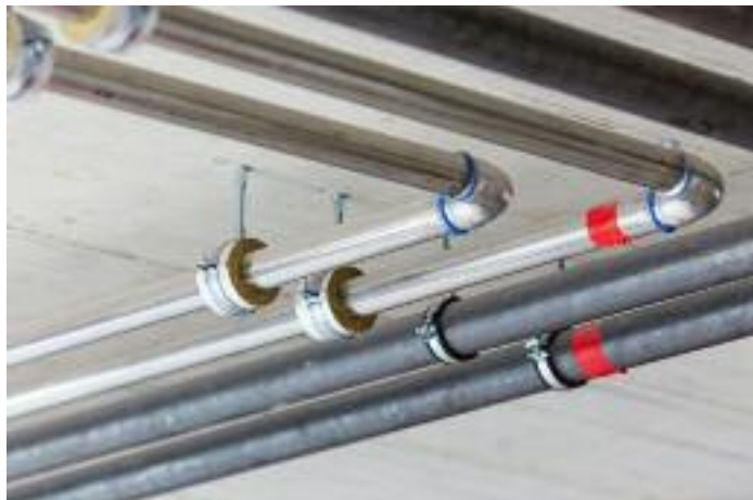
◀ Bild 2 • Rohrabhängung ohne Kältebrücken: Die „TECLIT Hanger“ umschließen mit einem Dämmkern aus druckfester Steinwolle die Kälteleitungen, wodurch ein potenzieller Wärmeeintrag im Bereich der Rohrhalterungen minimiert wird.
