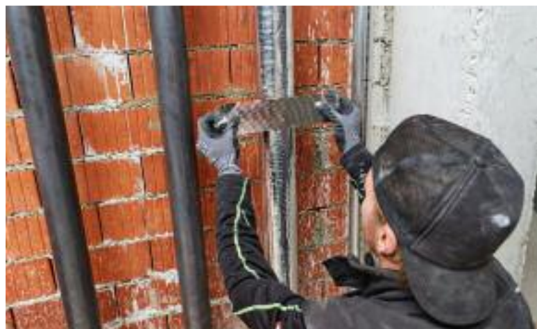
▶ Bild 8 • Das Alutape ist mindestens einmal um den kompletten Umfang zu wickeln und sollte dabei mindestens 20 mm zu beiden Seiten der Fuge überlappen. Für eine zusätzliche Lagesicherung werden die Rohrschalen im Abstand von maximal 600 mm umwickelt.
