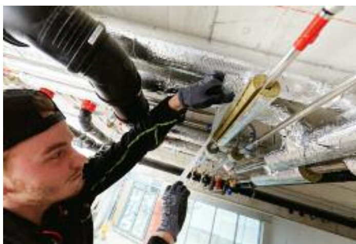
◀ Bild 4 • Dank der selbstklebenden Überlappung der Alukaschierung an der Längsfuge kann diese sofort dicht verschlossen werden.
