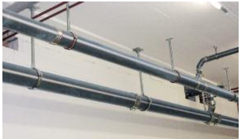
▲ Bild 11 • Nichtbrennbares gusseisernes Abflussrohrsystem mit Sonderbeschichtung Typ MLK-protec (Düker).
