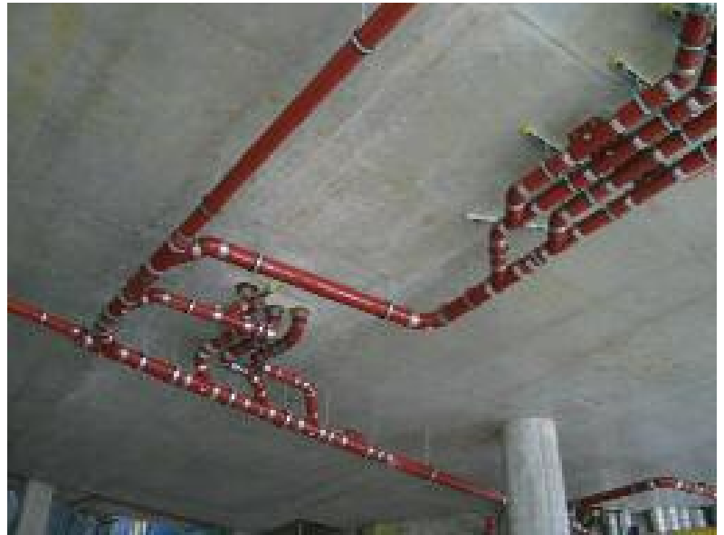
▲ Bild 10 • Nichtbrennbares gusseisernes Abflussrohrsystem PAM-Global S (SAINT-GOBAIN HES).
