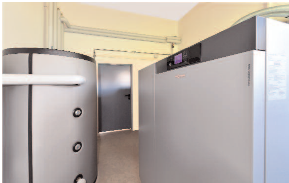
Heizzentrale im Firmengebäude der Jakob Sanitär & Heizung GmbH mit Pelletkessel Vitotigno 300-C und Heizwasser-Pufferspeicher Vitocell 100-E von Viessmann.
