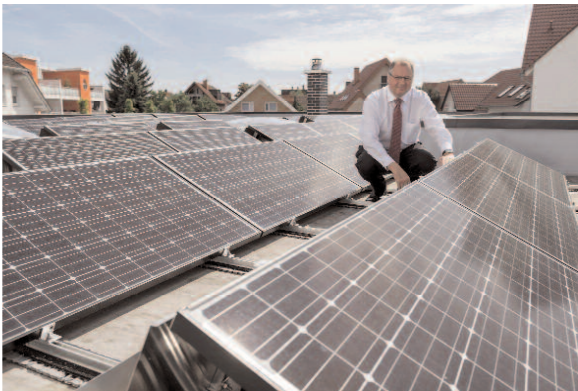
▲ Heinz Jörg Göbert auf dem Flachdach seines Bungalows inmitten von 74 Photovoltaikmodulen Bild: Panasonic / Heike Rost
