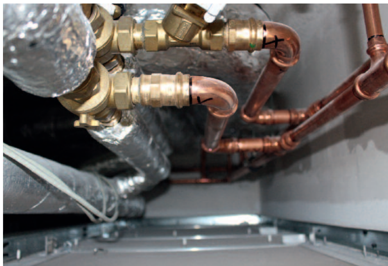
▲ Anbindeleitungen mit Kupferrohren für Heiz-Kühl-Decken.
