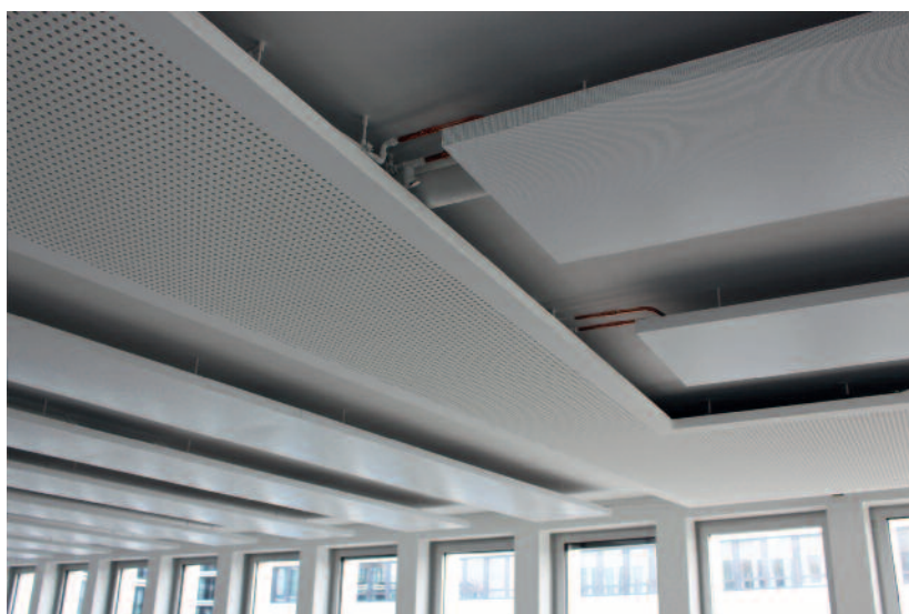
◀ Heiz-Kühl-Deckenelemente mit Kupferrohren.
