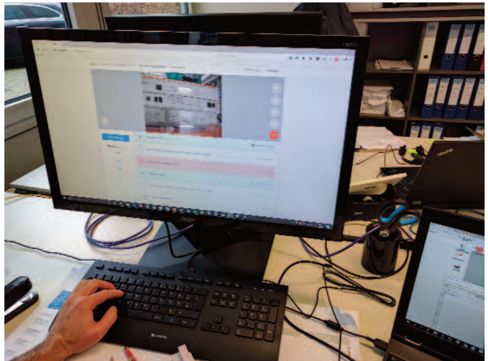
Die Kundenkamera hat das Display des Kessels erfasst. Der Handwerker fordert den Betreiber auf, die verschiedenen Temperaturen und Betriebszustände durchzudrücken, um sich aus der Ferne ein Bild vom Anlagenzustand machen zu können.
