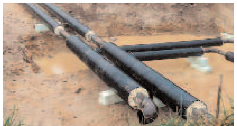
▼ Bild 10 • Verlegung Nahwärmesetz
